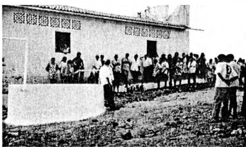
Cisterna construída pelo Peasa em Massaranduba
